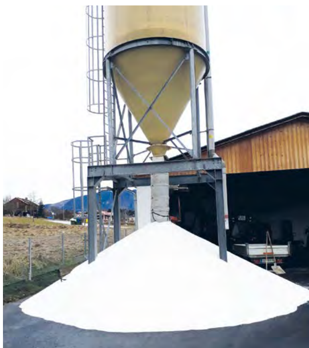
ASZ Streusalz von Silo ausgelaufen
